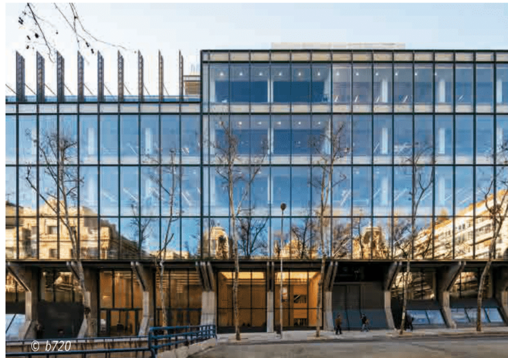
Rehabilitación edificio de Telefónica para oficinas. Diseño sostenible para conseguir unas oficinas eficientes. Fachada concebida para proporcionar luz natural a partir del acristalamiento continuo, combinado con sistemas de protección solar integrados para controlar la luz directa. La madera laminada presente en un muro cortina como cerramiento ventana. Obtuvo la certificación BREEAM Excelente, la máxima calificación posible. Imagen superior, vista de fachada; imagen inferior, vista del interior.
